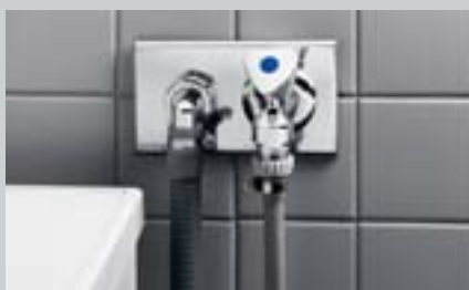
Канализационные сифоны с встроенным патрубком подачи воды
